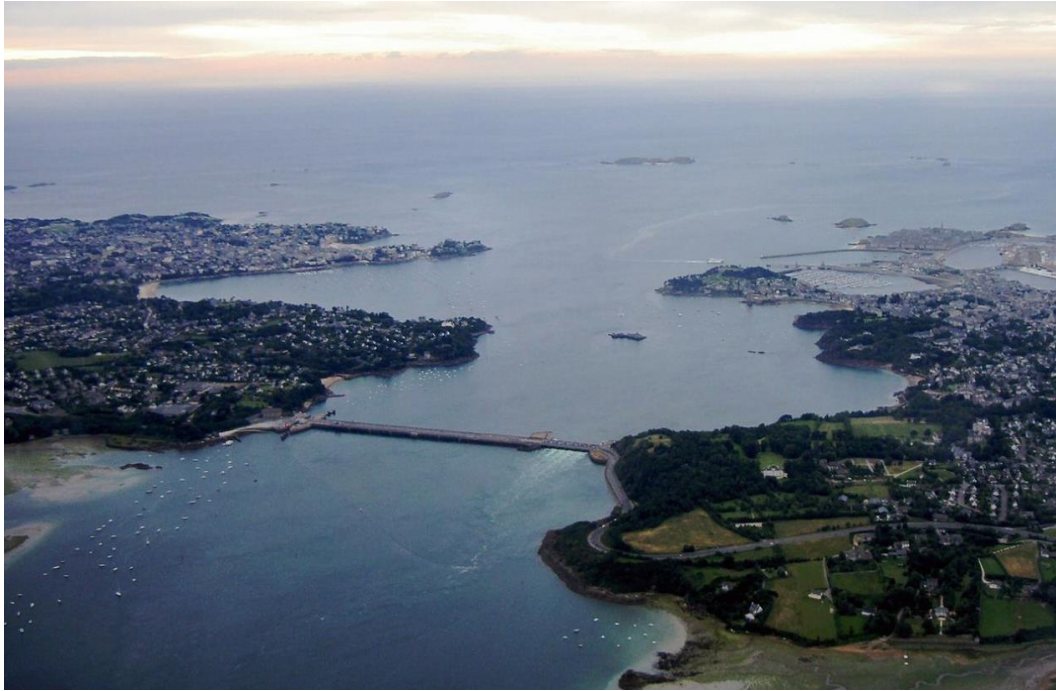
EDF Usine Marémotrice de la Rance, 240 MW
